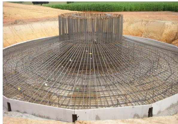
Photo 2 : Excavation et préparation de l'armature
