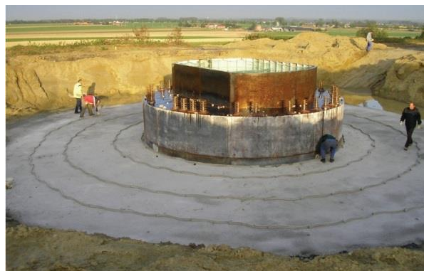
Photo 3 : Durcissement béton
