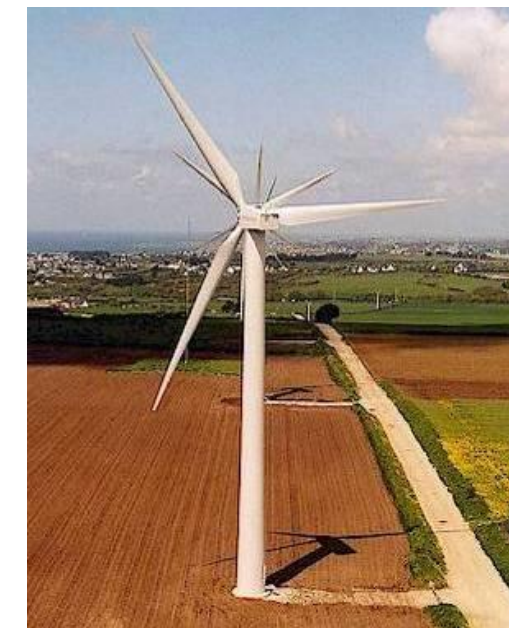
Photo 6 : Exemple de piste d'accès aux éoliennes
